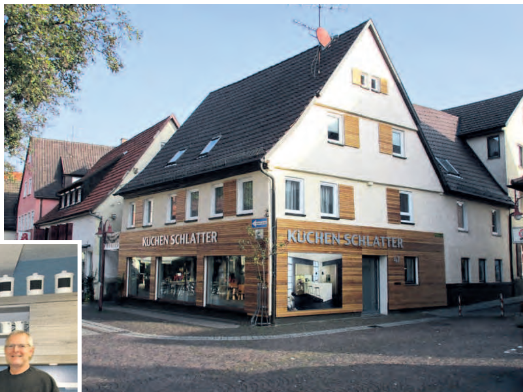
Das Küchenstudio nach Umbau 2016 in der Dettinger Straße 47.
